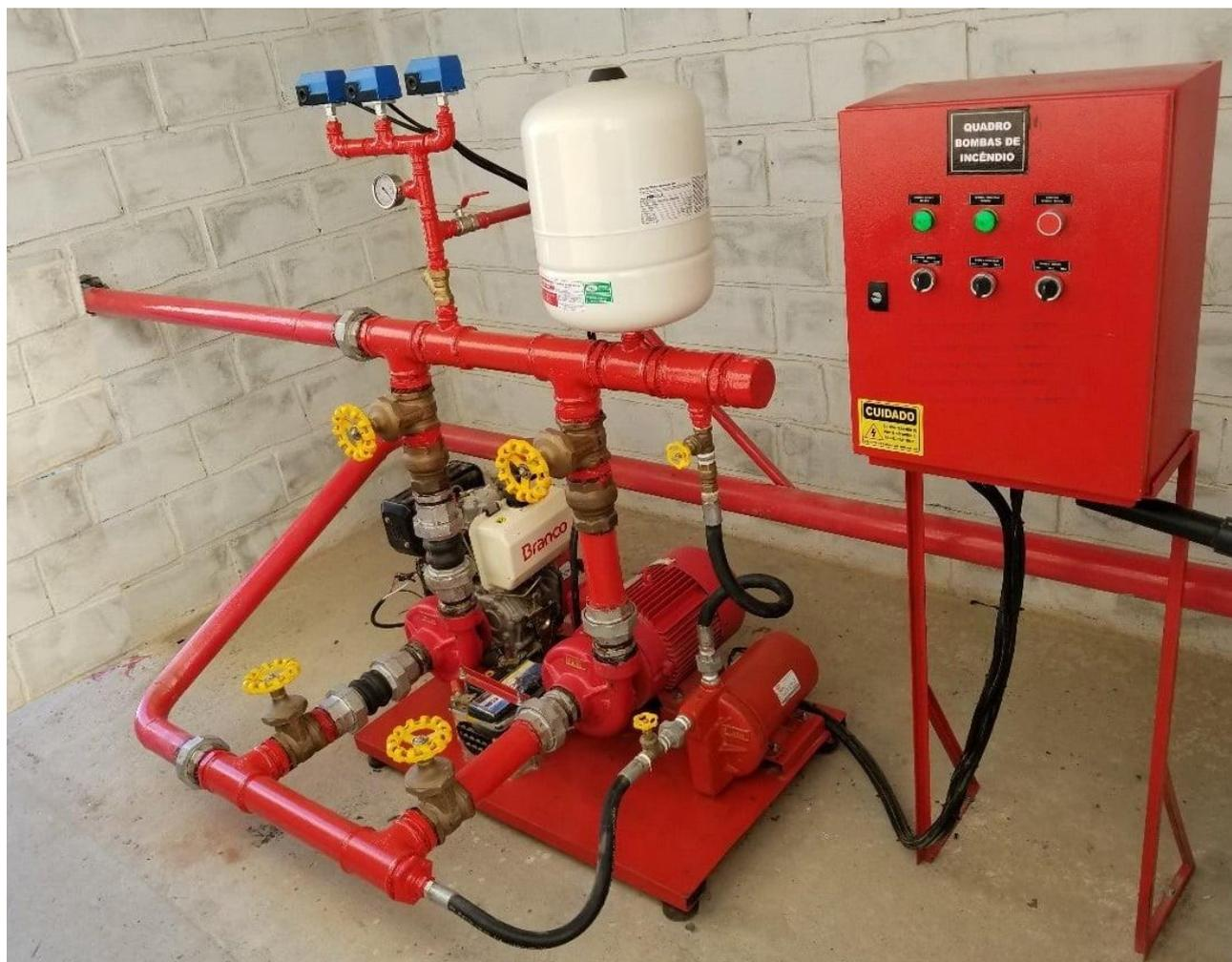
*Skid de Combate à Incêndio com bomba Jockey, bomba com motor à combustão e painel de comando*
